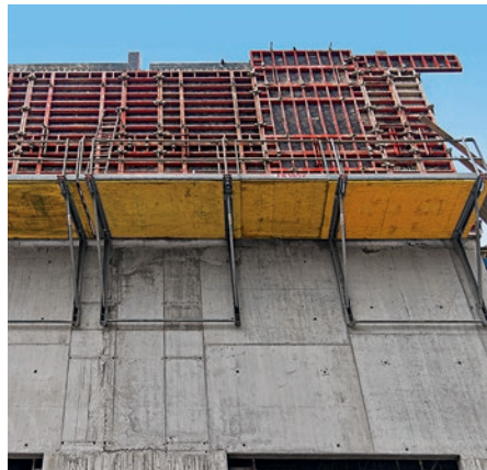
Pomost pośredni może być stosowany również jako pomost kompensacyjny. Luki o szerokości do 2 m kompensowane są bezstopniowo.
