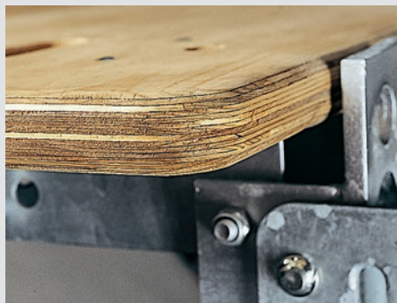
Poszycie pomostu z wielowarstwowej sklejki o grubości 45 mm.
