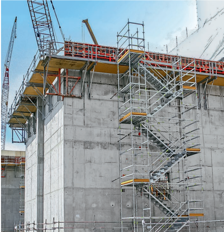
Pomost składany narożny do naroży zewnętrznych może być stosowany jako lewy i prawy. Wpływa to na redukcję potencjału i usprawnia transport.
