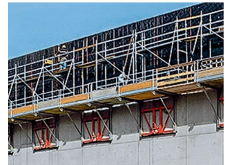
Zastosowanie pomostu składanego narożnego z rusztowaniem zbrojarskim PERI UP na ścianie prostej.
