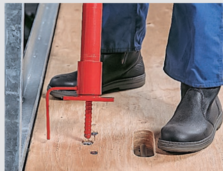
Słupek poręczy FBP do mocowania desek zabezpieczających osadza się i wkręca w otwór montażowy DW 15.
