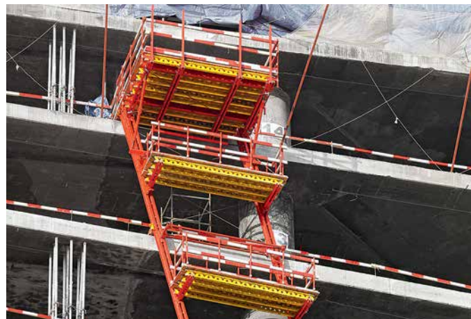
Wysuwnice mogą wspiąć się przy użyciu szyn za pomocą przenośnych siłowników hydraulicznych RCS – pozwala to dodatkowo zminimalizować użycie żurawia.
