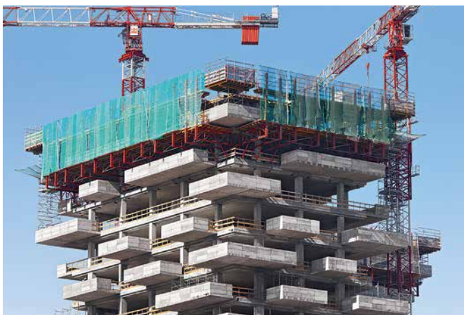
Evolution Tower wkręca się w moskiewskie niebo, wznosząc się na wysokość prawie 250 m i wykonując przy tym obrót o 150 stopni. Wysoki stopień bezpieczeństwa zapewniają ukośnie wspinające się bez użycia żurawia jednostki osłon zabezpieczających RCS.
