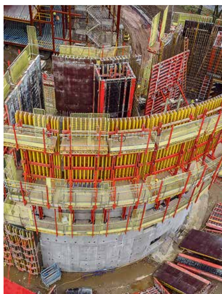
Zastosowanie lekkiego szynowego systemu wspinania z dźwigarowym deskowaniem ściennym VARIO GT 24 na budynku ze ścianami łukowymi.
