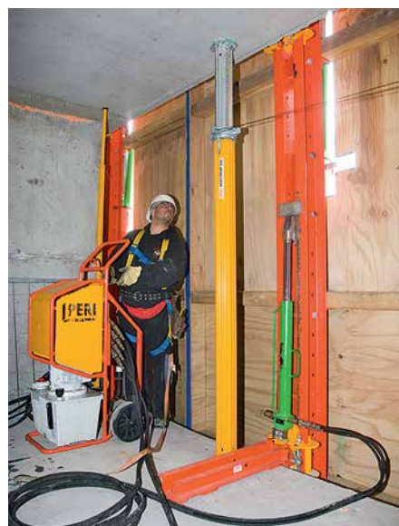
Jednostki są podnoszone z prędkością 1 m/min.
