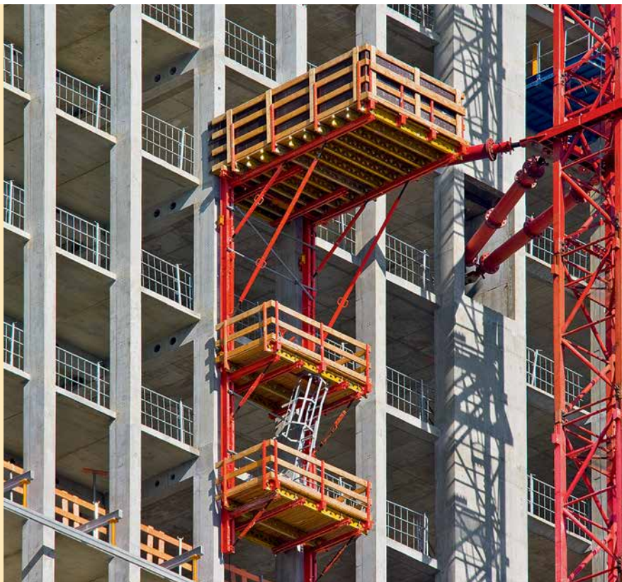
Samoczynnie wspinająca się wysuwnica RCS z dwoma podestami dolnymi jest zakotwiona w słupach obwodowych za pomocą uchwytu ściennego RCS.
