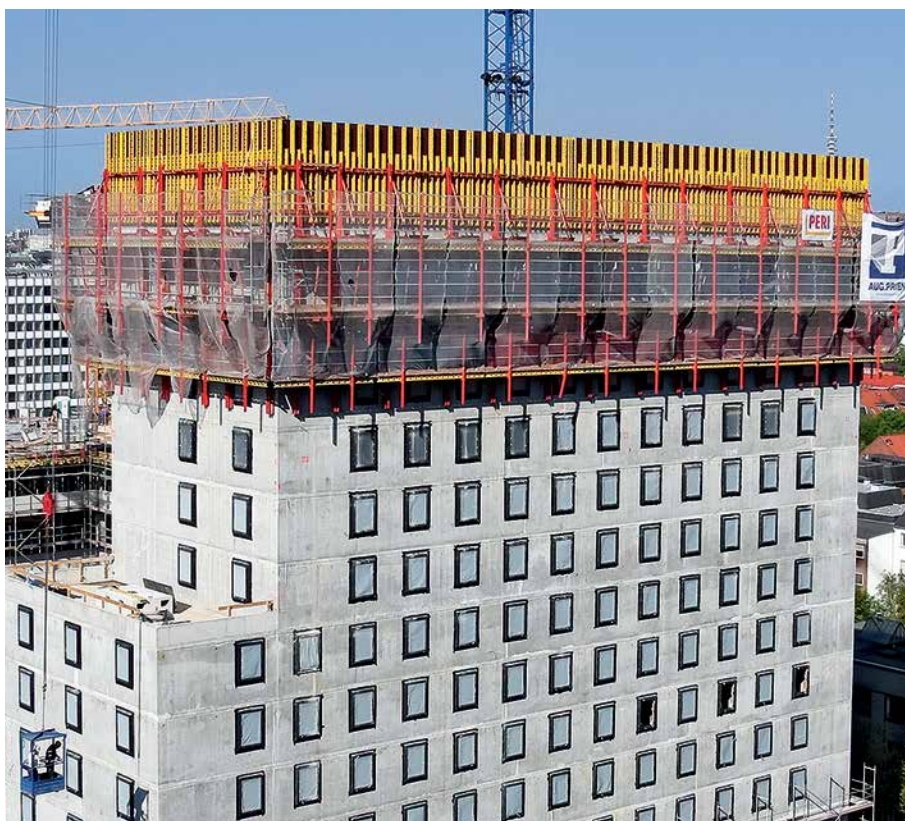
Pomosty robocze RCS C z osiatkowanym zabezpieczeniem bocznym zapewniają bezpieczne stanowiska pracy na dużej wysokości i po całym obwodzie budynku.
