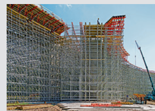
Rusztowania podporowe
