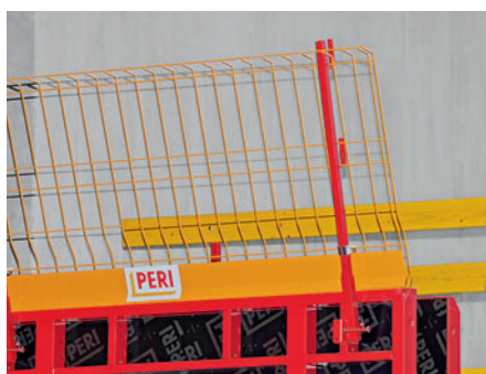
W przypadku desekowań ściennych siatki zabezpieczające można zastosować również jako poręczę.
