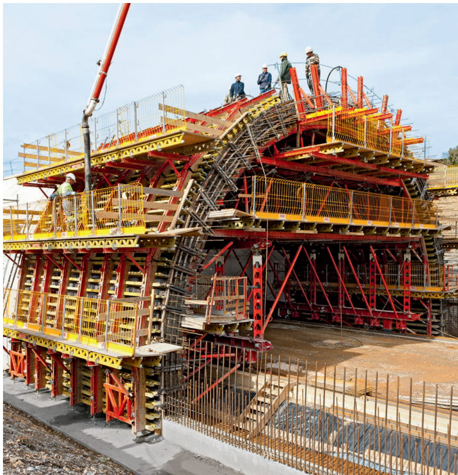
PROKIT EP 110 zapewnia zabezpieczenie krawędzi wszystkich pomostów roboczych przedstawionego deskowania tunelowego.
