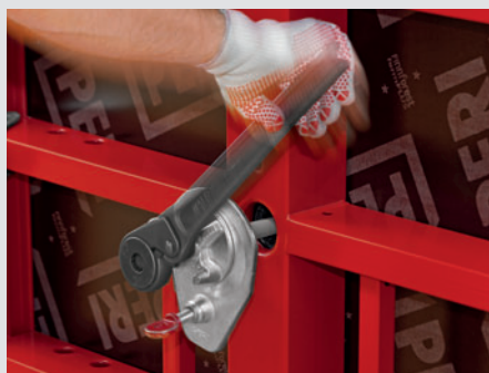
Dokręcić ściąg MX kluczem do ściągów MX na tyle, aby możliwe było ustawienie śruby z uchem.
