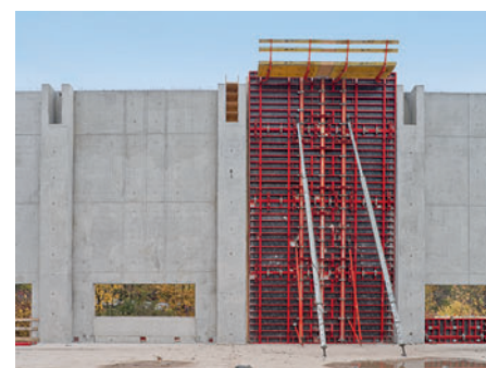
Potrójnie nadstawione, przestawiane jako jednostka kompletna, bez konieczności stosowania rusztowania roboczego po przeciwnej stronie. Scena do prób w Teatrze Miejskim, Stuttgart
