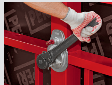
Przy pomocy klucza do ściągów MX dokręcić ściąg MX do oporu.
