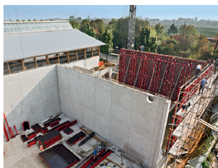
Wysokie, wyeksponowane powierzchnie ścian. Centrum Rehabilitacyjne Stuttgart-Fellbach
