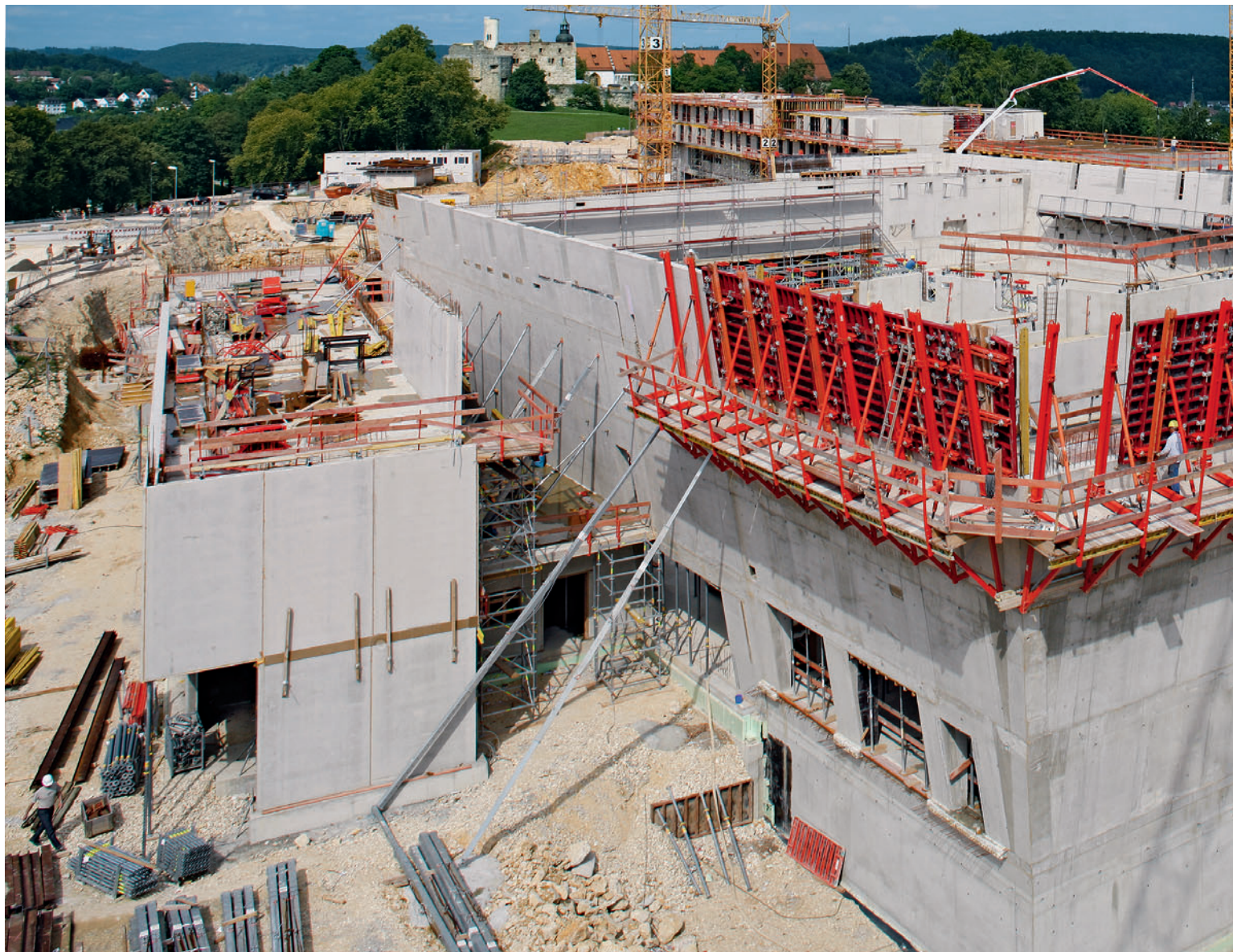
Krótki czas budowy - wysoki stopień bezpie- czeństwa. MAXIMO i system bezpieczeństwa PROKIT na pomostach do betonowania. Piwnica domu, Weissenhorn
