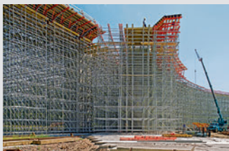
Rusztowania podporowe
