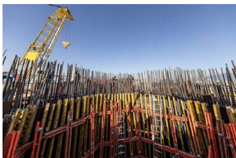
Zdjęcie 7 Skonsolidowana moc inżynierska: aby zrealizować wymagającą geometrię pylonu, inżynierowie z PERI opracowali indywidualne, dostosowane rozwiązanie formujące dla każdej sekcji konstrukcyjnej. (Zdjęcie: PERI SE)
