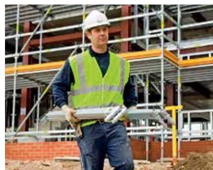
Niewielka szerokość rygla UH pozwala monterowi na transport jednocześnie czterech rygli.
