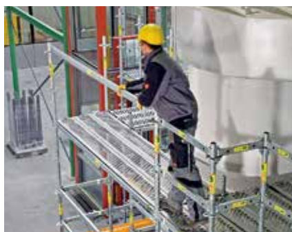
„Gravity Lock” pozwala na szybki montaż z bezpiecznej pozycji. Pod wpływem siły ciężkości klin rygla samoczynnie opada w otwór rozety.
