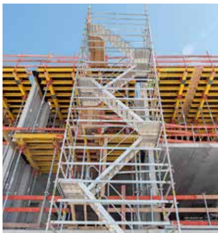
Schodnie z biegami aluminiowymi 75 zapewniają szybki i bezpieczny dostęp do wszystkich poziomów roboczych na placu budowy.
