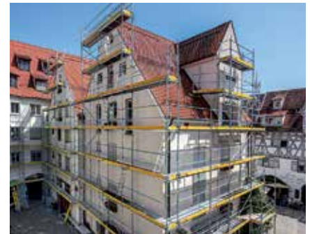
W standardowej konfiguracji montaż rusztowania odbywa się praktycznie bez łączników, a system szybkich zakotwień Easy skraca czas montażu.
