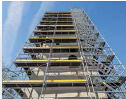
Dołączona do ramy Easy rozeta stwarza możliwość bezpośredniego łączenia z rusztowaniem modułowym PERI UP Flex, np. ze schodniami, bez stosowania dodatkowych ram i łączników.
