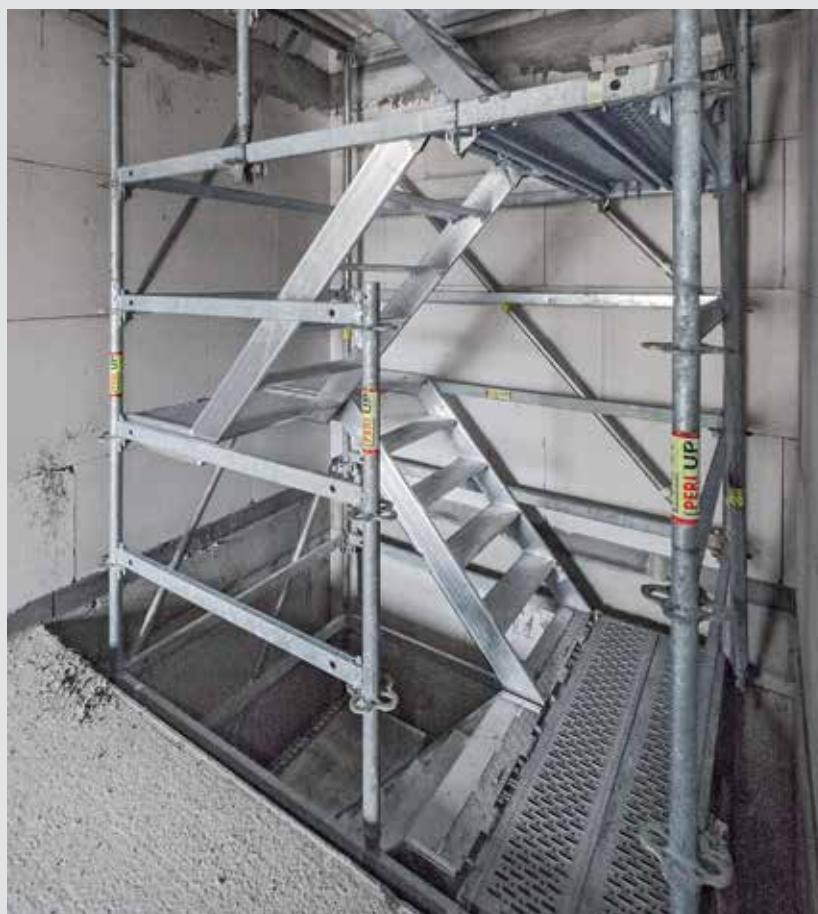
Krótkie biegi schodowe o szerokości 75 cm zapewniają maksymalne możliwości dopasowania w przypadku ciasnych pomieszczeń i ograniczonej geometrii.
