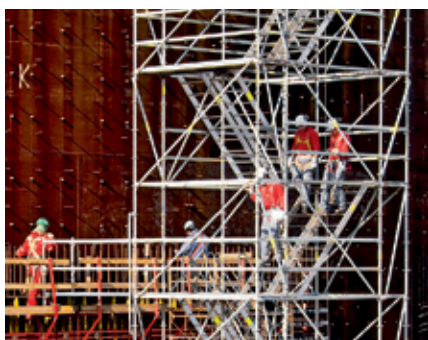
Dopasowanie do otworów budynku odbywa się za pomocą krótkich biegów schodowych zamontowanych na zewnętrznych wspornikach – niezależnie od wysokości kondygnacji.
