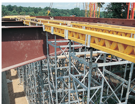
Trzpień z głowicą krzyżową stabilnie podpira pojedyncze lub podwójne dźwigary GT 24.
