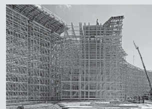
Rusztowania podporowe
