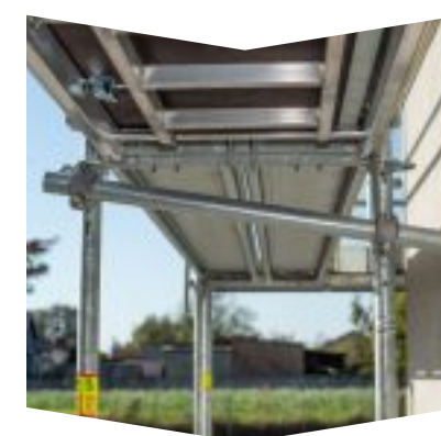
Łącznik kotwiący zamontowany w górnym otworze (słupek zewnętrzny) i dolnym otworze (słupek wewnętrzny)
