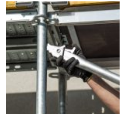
Montaż dolnej nieruchomej głowicy.
