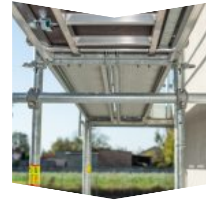
Łącznik kotwiący zamontowany w obu dolnych otworach
