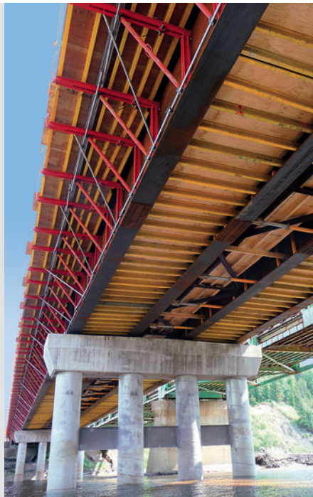
Obiekty o konstrukcji zespolonej Most Chinchage, Kanada Dźwigary z płytą realizowaną „in situ”
