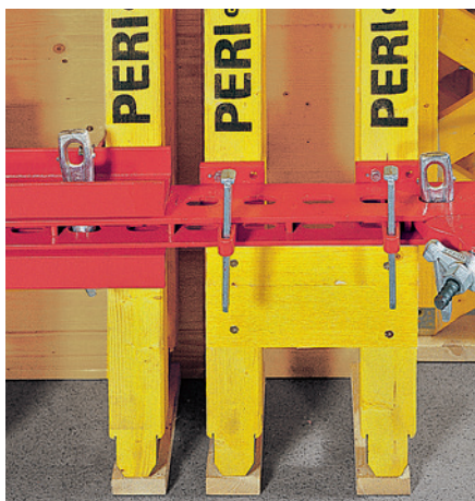
Poszerzenie płyt w VARIO wykonuje się również z elementów systemowych.
