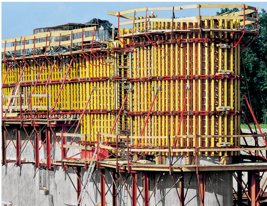
Strona czołowa filara. VARIO w połączeniu z systemem desek łukowych GRV na pomostach roboczych KGF 240.
