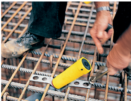
Proste mocowanie zakotwienia do zbrojenia: za pomocą drutu wiązkowego i obcęgów.
