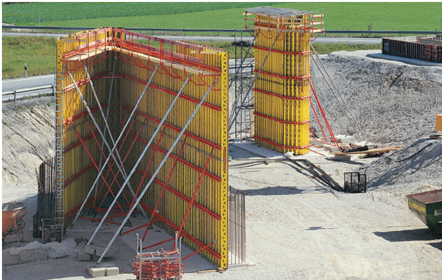
Przyciółek i filar mostowy zadesko- wany VARIO GT 24. Konstrukcja wielo- poziomowego skrzyżowania linii ko- lejki miejskiej w kierunku lotniska w Monachium.
