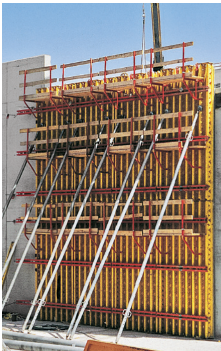
Zdjęcie przedstawia deskowanie VARIO GT 24, wykorzystane do budowy budynku administracyjnego.
