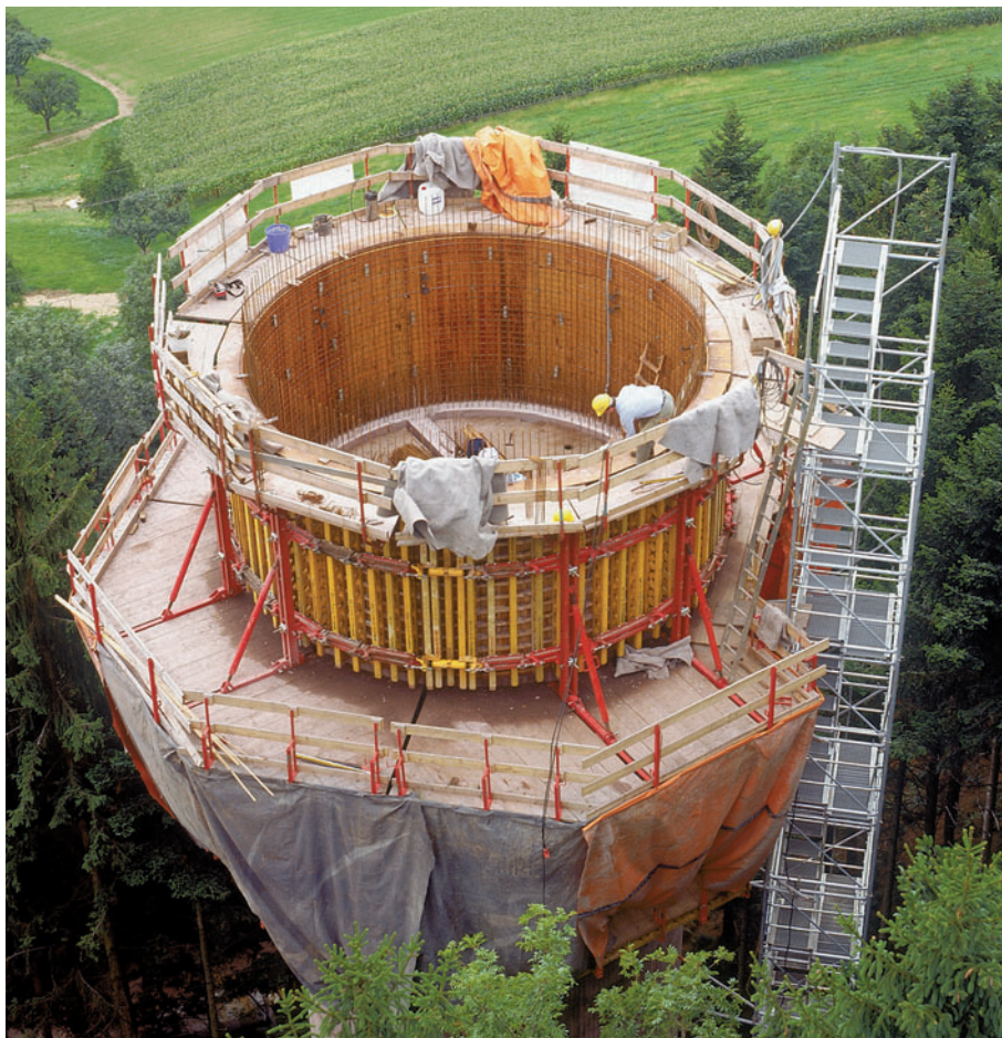
Deskowanie łukowe GRV na pomostach roboczych KGF 240
