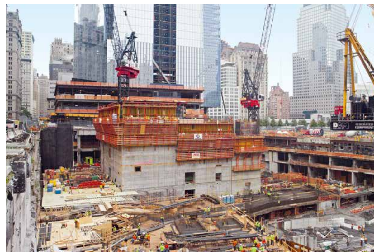
Ponad pół tysiąca zrealizowanych obiektów wysokościowych na całym świecie najlepiej świadczy o korzyściach płynących ze stosowania systemów samoczynnego wspinania ACS.
