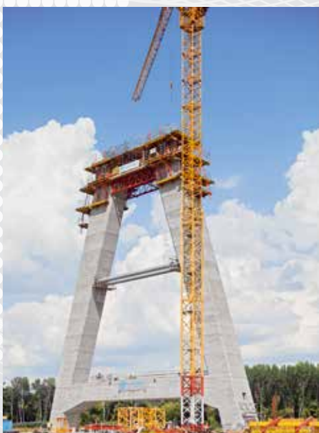
Pylon mostu na Drawie – Osijek, Chorwacja
