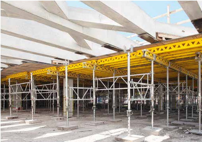
MULTIFLEX wykorzystano do wykonania podciągów w technologii betonu monolitycznego, wieże podporowe utworzono z podpór PEP połączonych ramami PRK.
