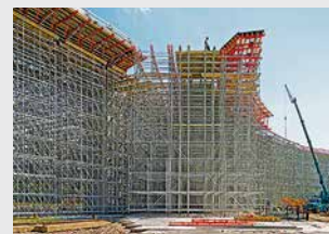
Rusztowania podporowe
