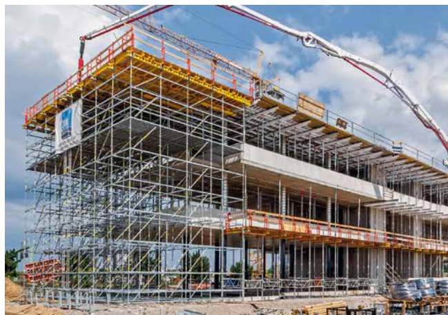
Kompleksowe rozwiązanie z jednego źródła: deskowania ściennie oraz stropowe, jak również rusztowania podporowe i zbrojarskie zostały optymalnie dopasowane do wymagań projektowych.
