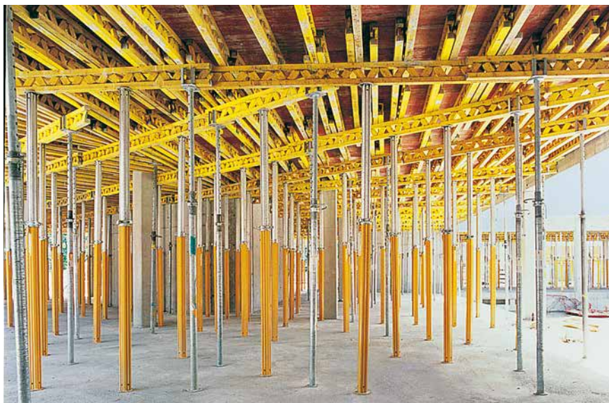
MULTIFLEX z użyciem podwójnych dźwigarów GT 24 dla optymalnego dopasowania do geometrii okrągłego zbiornika.
