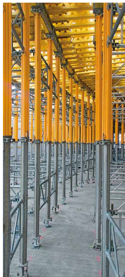
Poziomy ruszt nośny zbudowano z dźwigarów kratowych GT 24, zastosowanych jako podwójne dźwigary główne oraz rozdzielcze.
