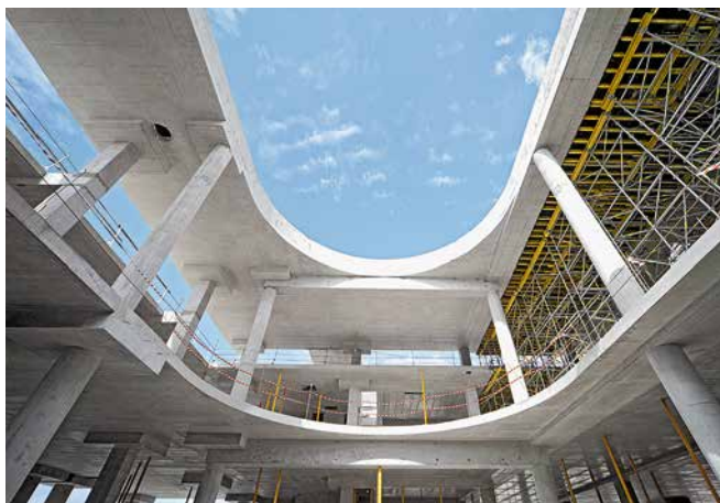
Żelbetowe stropy o grubości 30 cm realizowano w systemie MULTIFLEX.
