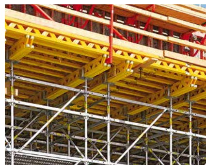
Podwójne dźwigary GT 24 zwiększają wykorzystanie nośności rusztowania podporowego PERI UP Flex na dużych wysokościach.
