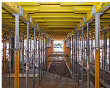
Zastosowanie dźwigarów GT 24 zmniejsza zużycie dźwigarów, rygli stalowych oraz podpór, a to oznacza redukcję kosztów materiału i robocizny.
