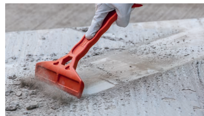
Pozostałości betonu łatwo usunąć za pomocą skrobaka.
