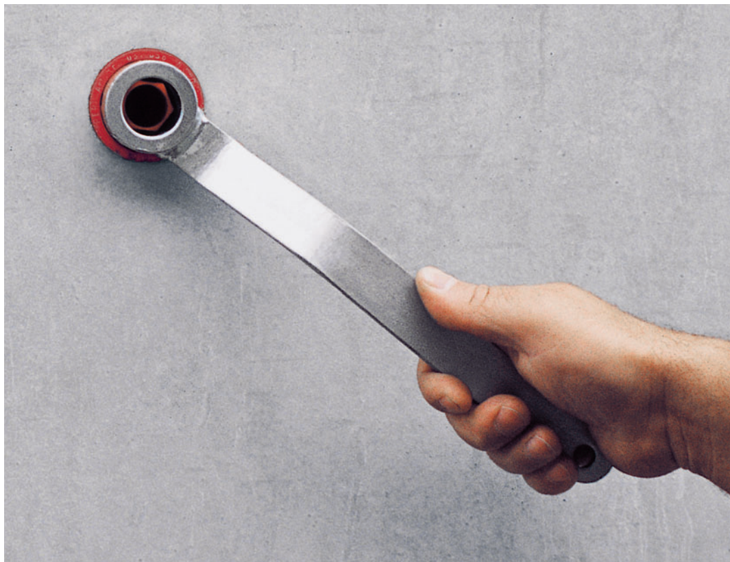
Demontaż stożka uszczelniającego DK przy pomocy klucza do stożków DK UNI.
