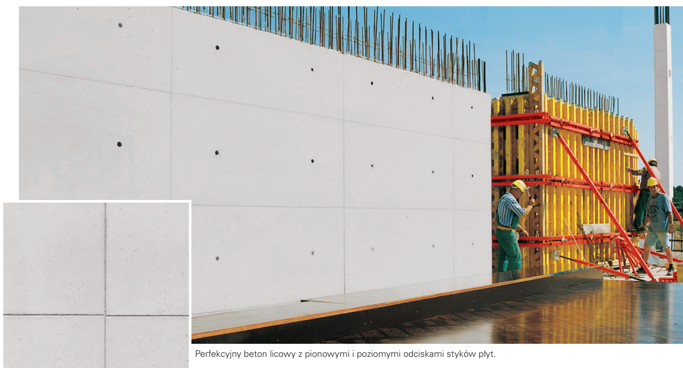
Ściany hali w Neubiberg. VARIO z uporządkowanym rozstawem ściągów. Poszycie zostało przykręcone od spodu.
