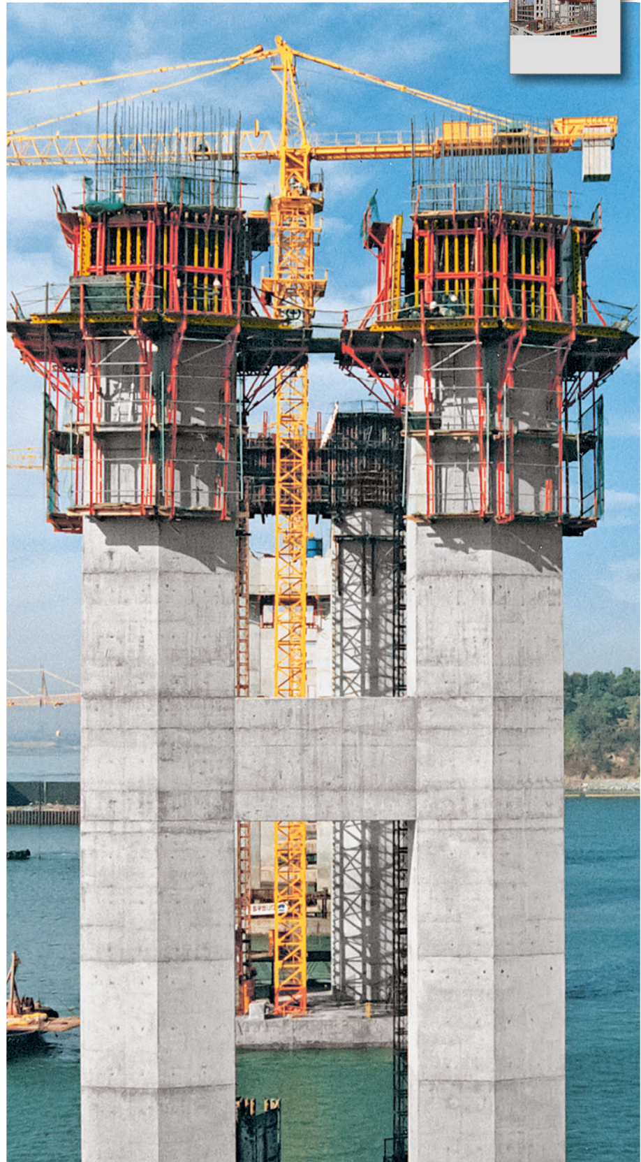
CB 240, trójkątny wspornik pomostu roboczego do bezproblemowego przebiegu robót po obu stronach deskowania.
