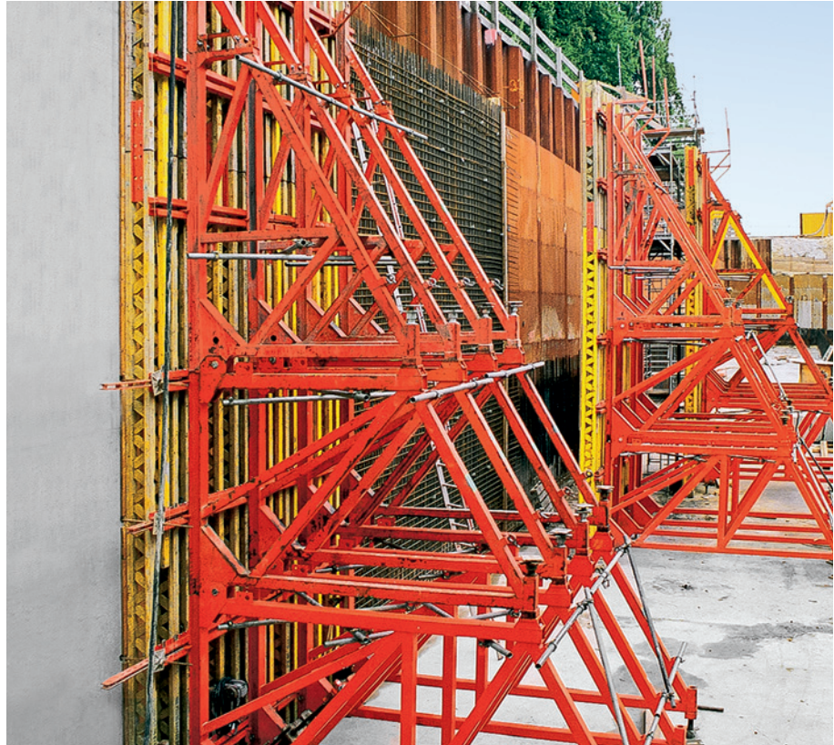
Kozły oporowe SB-A0, A, B, C z deskowaniem VARIO GT 24 do maks. wysokości deskowania 8,75 m.
