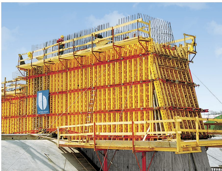
Tył filara. VARIO GT 24 umożliwia proste dopasowanie do geometrii nachylonego filara.
