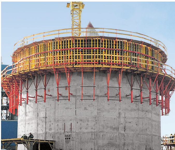
VARIO GT 24 na budowie zbiornika okrągłego. Drewniane kliny pomiędzy dźwigarami i ryglami stalowymi nadają łukowy kształt.
