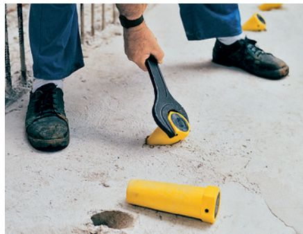
Demontaż korka kotwi odbywa się przy pomocy klucza płaskiego S 70.
