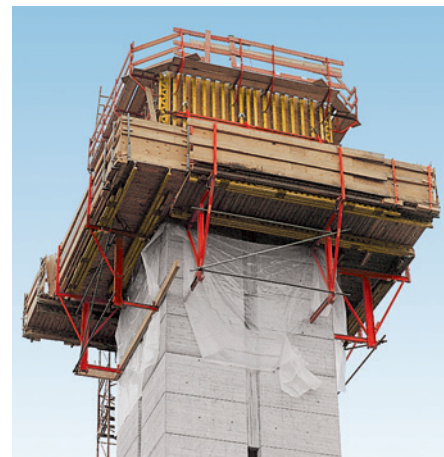
Wieża kościelna w Feldmoching koło Monachium. VARIO GT 24 na pomostach roboczych KGF 240.
